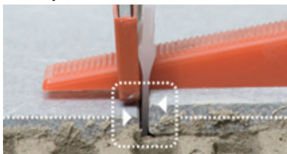
段差がある状態
